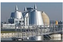
Klärschlammbehandlungsanlage Zagreb, Kroatien
