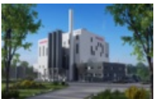
Energieoptimierte Klärschlammverbrennung Hannover-Lahe, Deutschland
