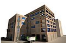
Klärschlammverwertungsanlage Kläranlage Bello, Kolumbien
