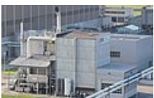
Klärschlammverbrennungsanlage Dürnrohr, Österreich
