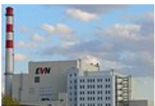
Thermische Abfallverwertungsanlage MSZ3 Moskau, Russland
