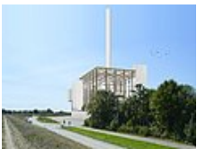
Monoverbrennungsanlage zur Verwertung von Klärschlamm in Straubing, Deutschland
